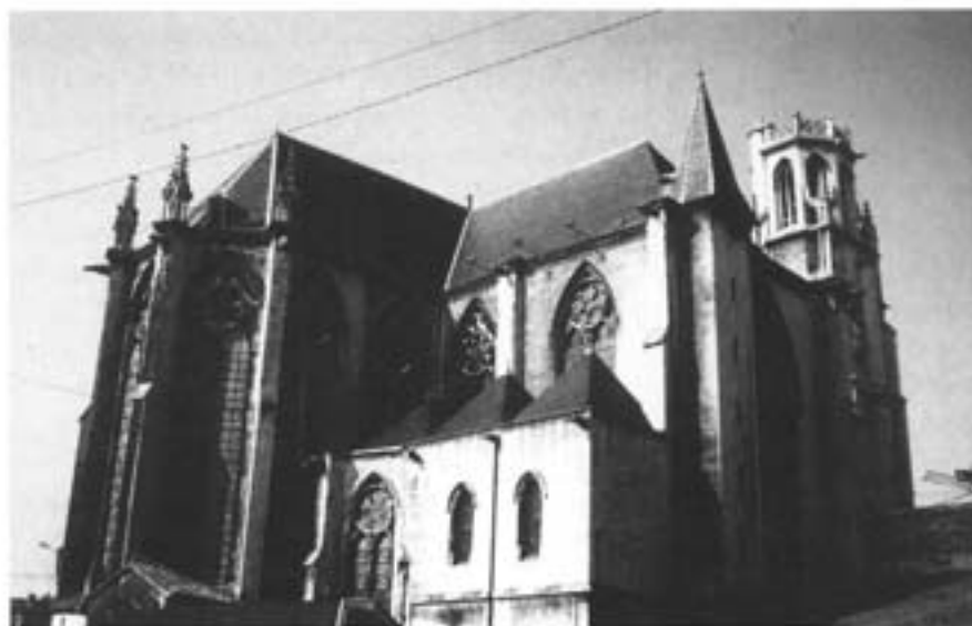
Fig. 26. Toul, ancienne collégiale Saint-Gengoult (photo : I. Hans-Collas, 1991).
