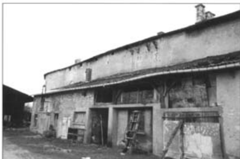
Vue sur les murs. Noter les corbeaux et pignons qui rappellent le chemin de ronde.
