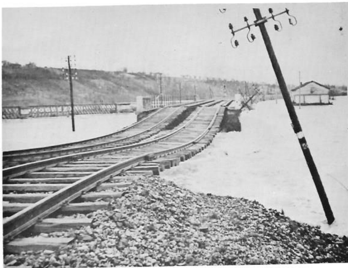
Le même pont du chemin de fer (décembre 1947) — Cliché R. CAVADINI
