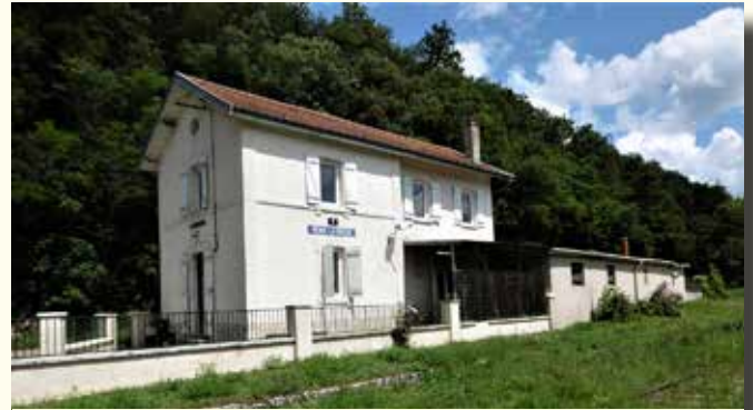
L'ancienne « halte-station » ferroviaire de Pierre-la-Treiche installée à la fin du XIX e siècle (Cliché J.-P. AUBE)
