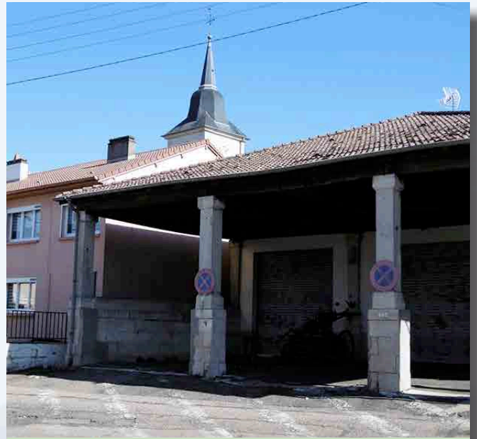
L'ancienne halle, reconstruite en 1692, où se tenaient marchés et foires.
