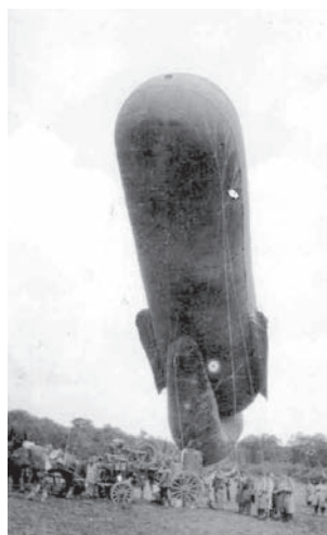
3. Le ballon en ascension, équipé du treuil à vapeur monté sur un chariot hippomobile. (Collection F Steinbach)
