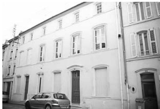
Fig. 11 : Immeuble de rapport, rue Michâtel.
