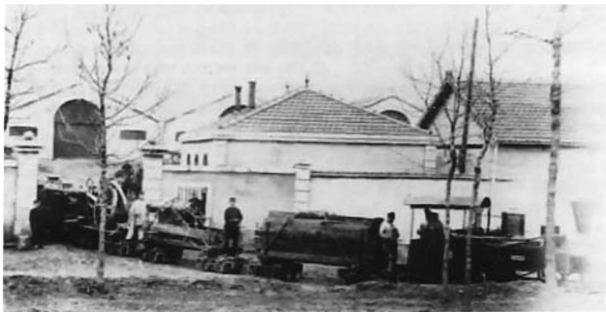
Train sortant de l'arsenal de Toul, tracté par une locomotive Decauville
