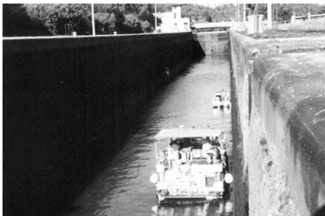
Ecluse de Fontenoy
