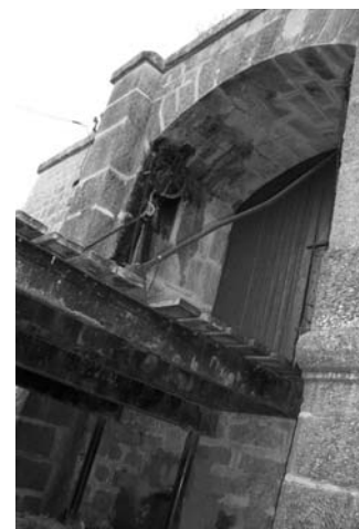
Entrée de la batterie nord
