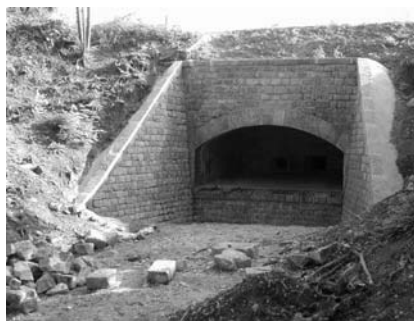
Coffre de défense de la courtine nord restauré en 2000
