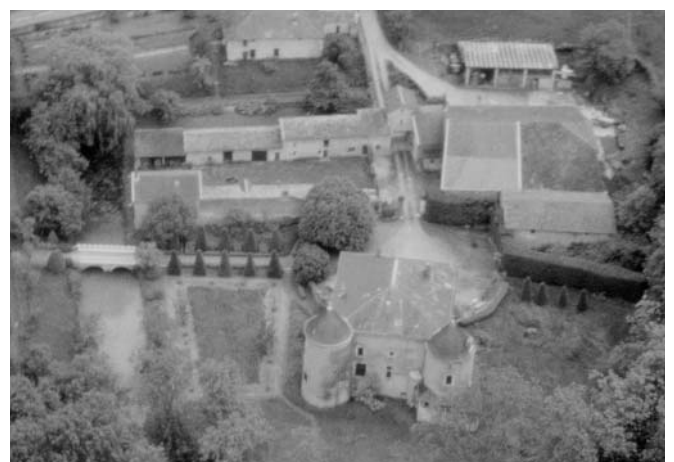
Vue aérienne du site castral (Cliché Ph. Frigério, 1996)
