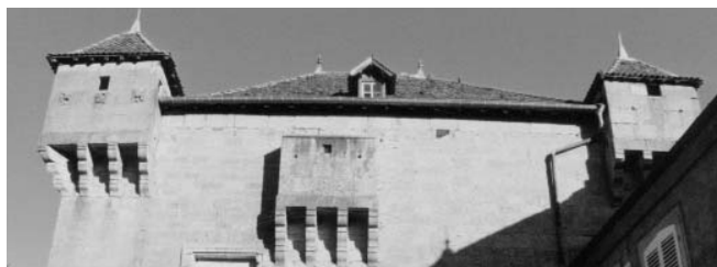
"Tour carrée" façade sud ouest (Novembre 1999)
