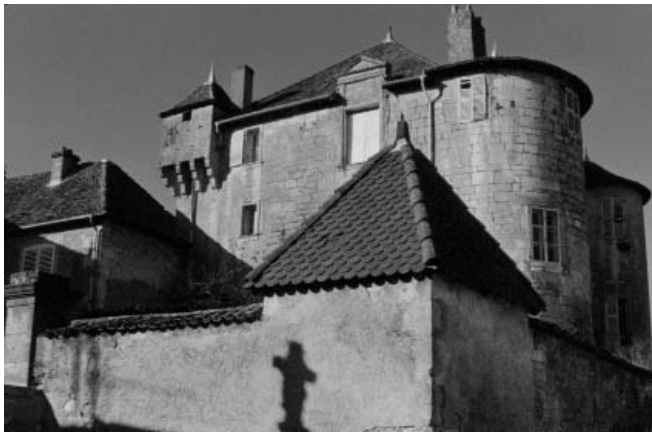
"Tour carrée" côté tourelle Est (Novembre 1999)
