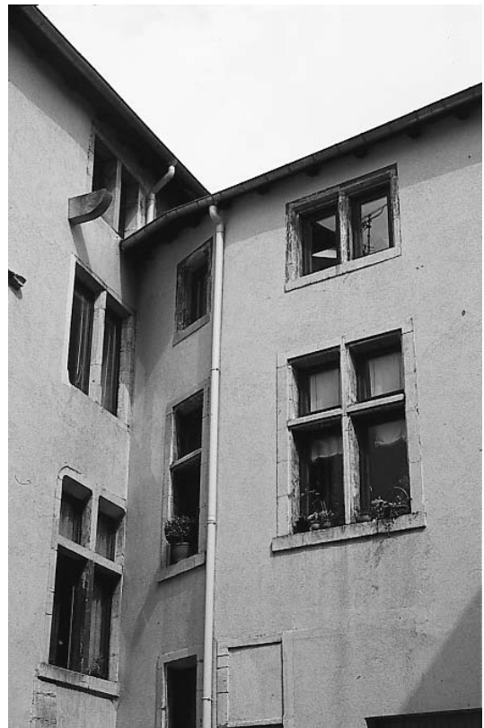
Cour intérieure, rue Pont des Cordeliers.
