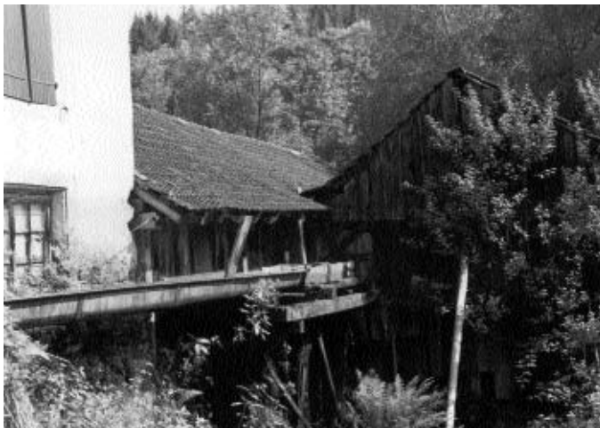
Vue arrière du haut-fer avant restauration de la roue d'eau
