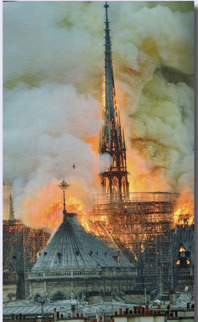
Incendie de Notre-Dame de Paris, embrasement de la charpente, après celle de la flèche (photo Agence France-Presse).
