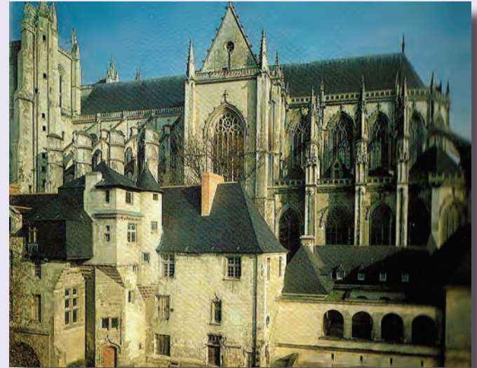
Cathédrale de Nantes, flanc sud après reconstruction des combles, photo. A. Villes.
